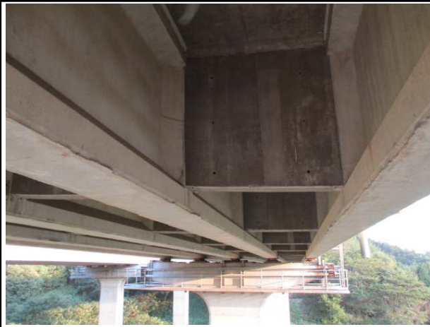
거더 및 가로보
